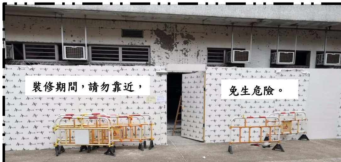
中心辦公室、飯堂正在進行裝修工程
